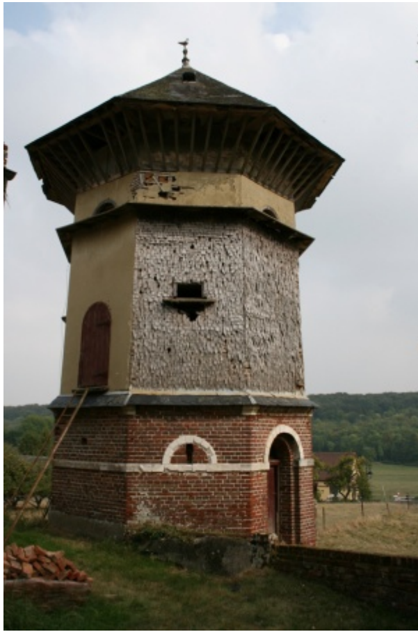
Pigeonnier recouvert de bardeaux de bois situé à Avesnes-Chaussoy.
