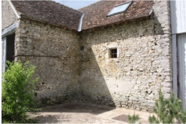
Etat des murs avant enduit. Crédit : Bernard Fauquembergue
