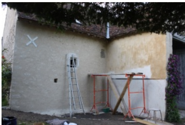
Premier essai insatisfaisant pour la couleur et la tenue. Crédit : Bernard Fauquembergue
