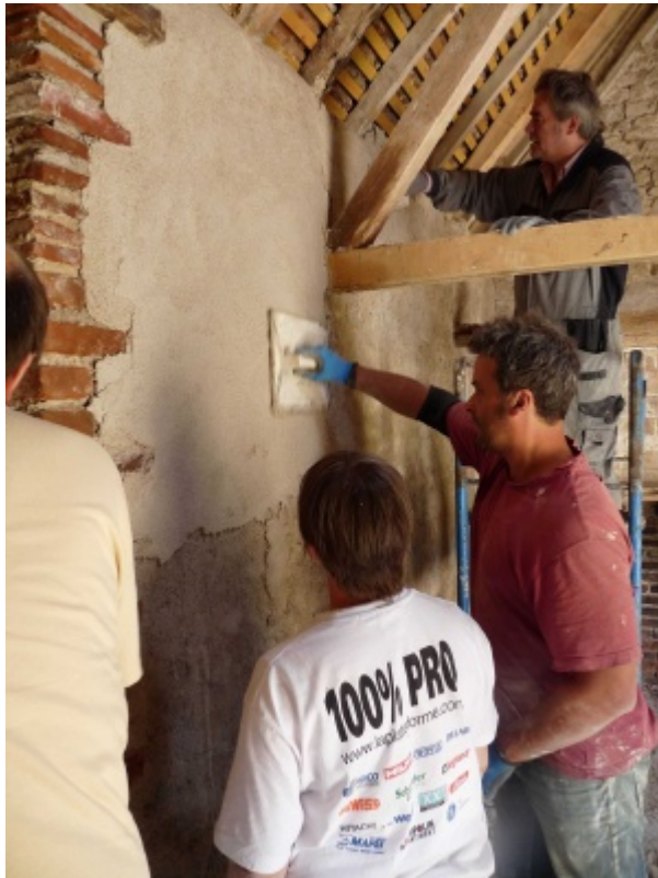
Pose de l'enduit de finition sur des murs intérieurs.
