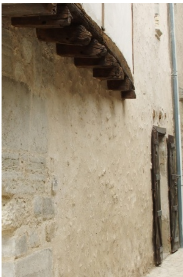
Mur enduit à la chaux.
