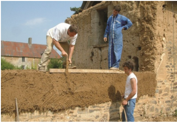
Taille au bâton d'un mur en bauge. Photo François Streiff, Parc Naturel Régional du Marais du Cotentin et du Bessin ©
