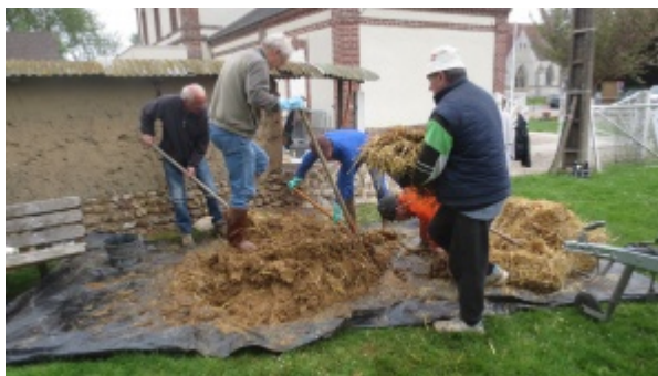
Préparation de la bauge : ajout de paille à la terre humide
