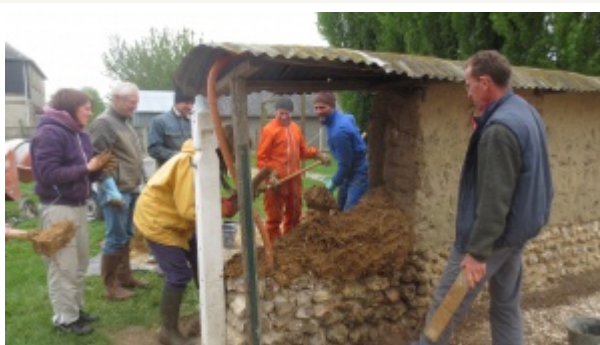
Pose de bauge avec fourche
