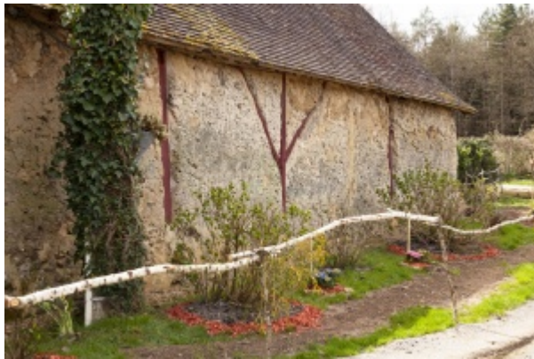
Vibraye, la Fontaine de Guette-Loup, façade arrière de la maison et ses renforts en bois. Photo CEMJKA-Perche Sarthois, 2018.
