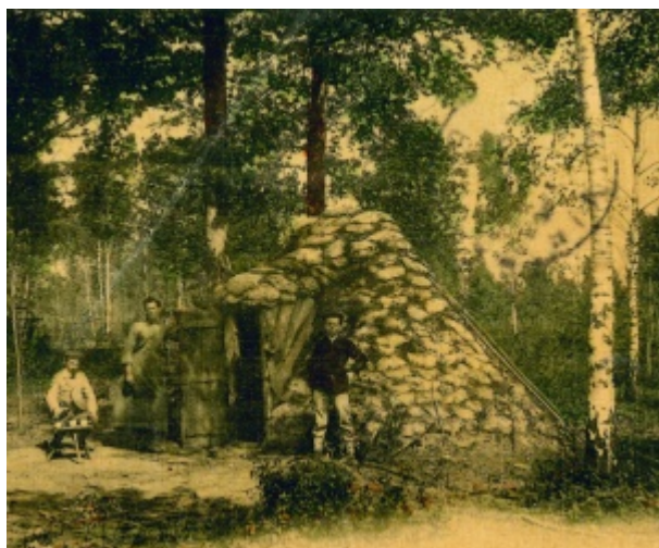
Loge de charbonnier en forêt de Vibraye au début du XXe siècle. Sa construction en mottes de terre agglomérées semble proche de l'une des techniques de la bauge. Collection privée.
