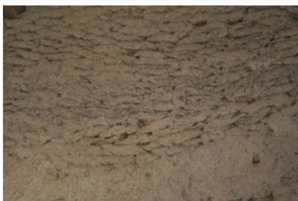
Préval, les Pâtis, détail du montage par alignement de mottes du mur de la grange-étable. Photo Perche Sarthois, 2006.
