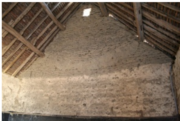
Préval, les Pâtis, vue intérieure de la grange avec détail du montage par alignement des mottes. Photo Perche Sarthois, 2006.
