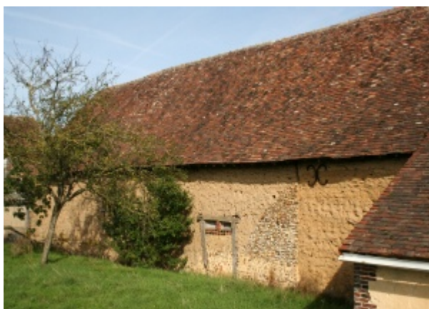
Préval, les Pâtis, façade arrière de la grange-étable en bauge avec renforts en rognons de silex. Photo Perche Sarthois, 2006.
