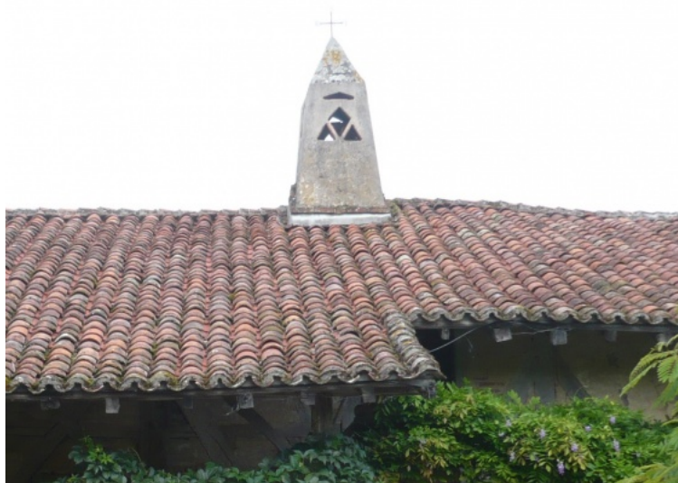
Cheminée sarrasine de la Ferme de Montalibord.Photo Maisons Paysannes de France © Délégation de l'Ain.
