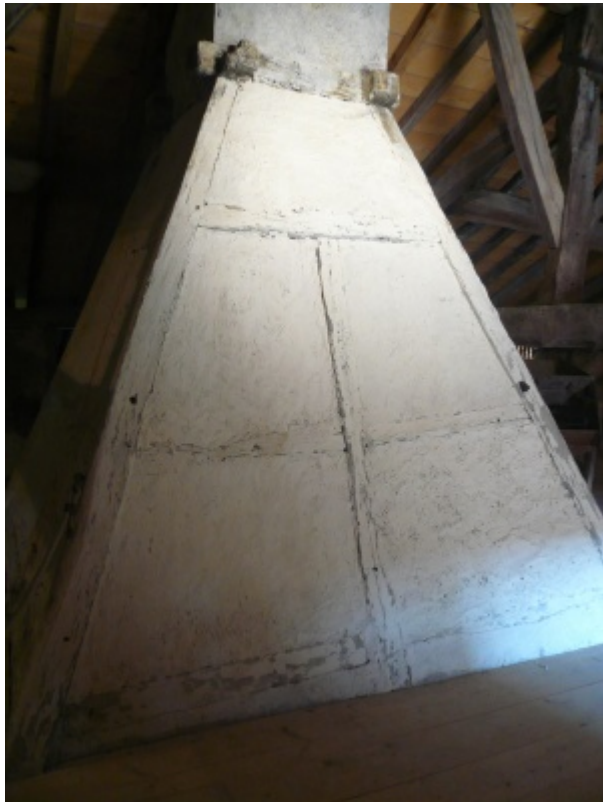
Conduit de cheminée en pan de bois et torchis, ferme du Champ-Bressan, actuel Musée du terroir, Romenay (71).
