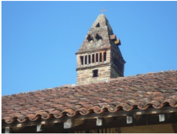
Mitre de cheminée sarrasine située au Musée du terroir, ferme du Champ-Bressan, Romenay (71).
