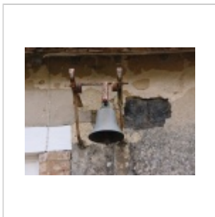
Cloche accrochée sur la façade - Commune de Ballon-Saint Mars© Patrick Dejust
