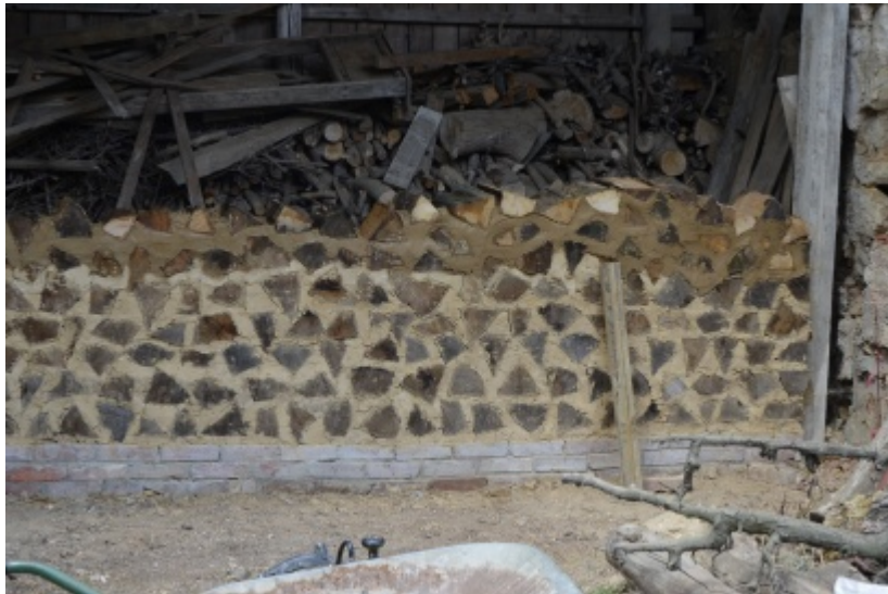
Mur en bois cordé en cours de construction.
