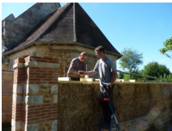
Mur de paille édifié.
