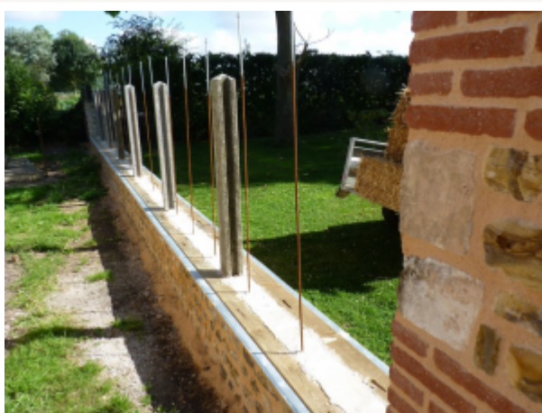
Soubassement du mur en paille.
