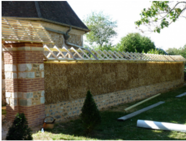
Mur en paille sur lequel repose l'ossature du chaperon.
