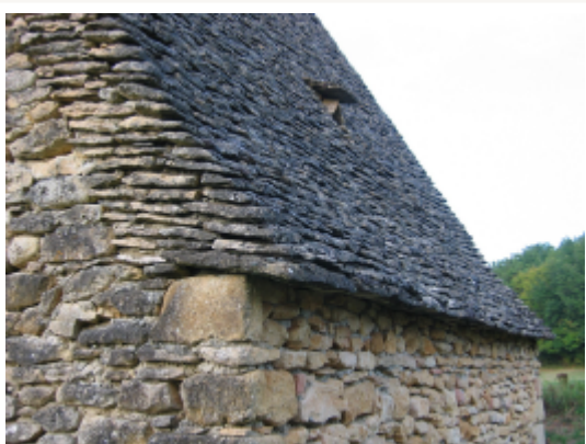
Rive de toit sans débord en laves calcaire. Sur la couverture, présence d'un houteau servant à aérer la sous couverture.
