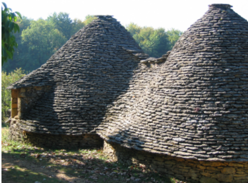
Toit conique en lave calcaire des Cabanes du Breuil, situées à Saint-André-d'Allas, Dordogne (24).
