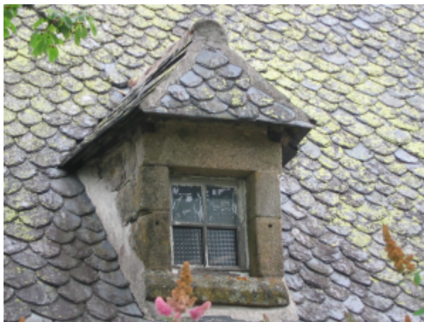
Toit et lucarne en pierre couvert de lauzes de schiste.
