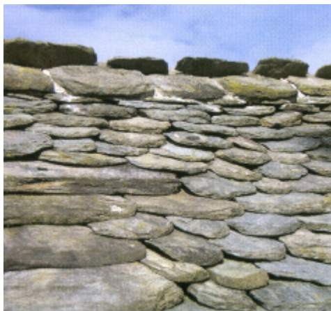
Toiture en lauze du Cayrol avec faîtage en peigne (ou faîtage croisé)
