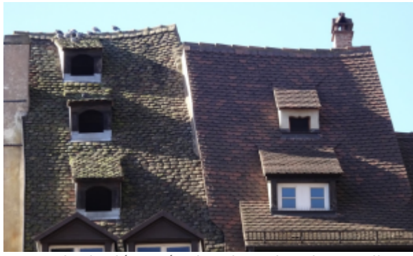
Exemple de déversée des rives de toit avec ligne de faîte concave.
