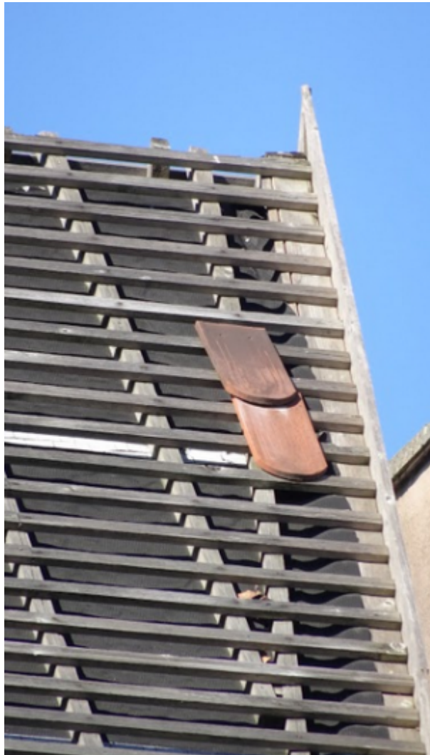
Essai de pose de tuiles plates sur liteaux, Strasbourg
