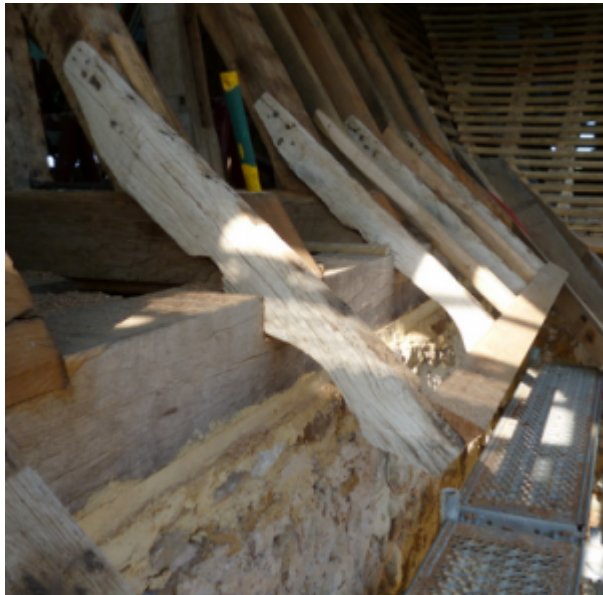
Chanlatte disposée sur des coyaux, eux-mêmes fixés sur les chevrons.
