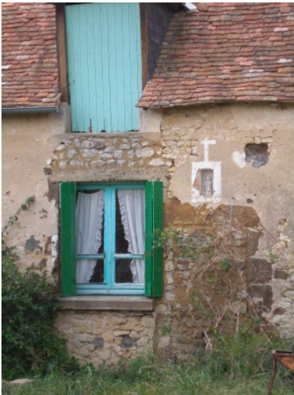
Croix peinte à la chaux surmontant une niche encadrée peinte à la chaux ainsi qu'un cœur peint, située à Mézières-sous-Lavardin
