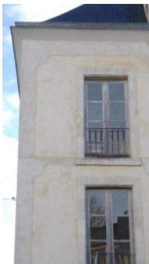
3 - Quarts de rond sur une maison restaurée au Mans, cité Plantagenêt.
