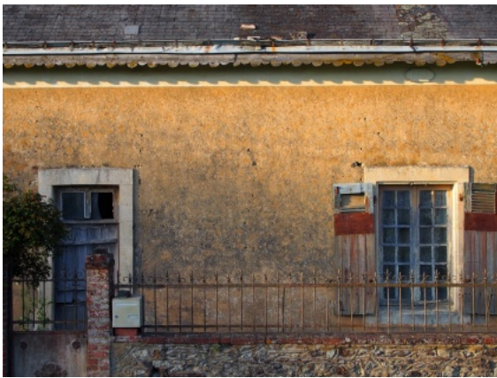
7 - Sur cette maison de Domfront-en-Champagne, l'enduit vient buter sur les encadrements de pierre en léger débord. Photo P. Dejust © Maisons Paysannes de la Sarthe.
