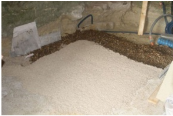
Dalle de chaux-chanvre lissée.
