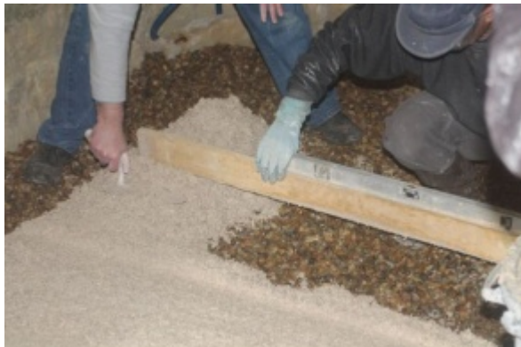
Pose du mélange chaux-chanvre et lissage avec règle de maçon.
