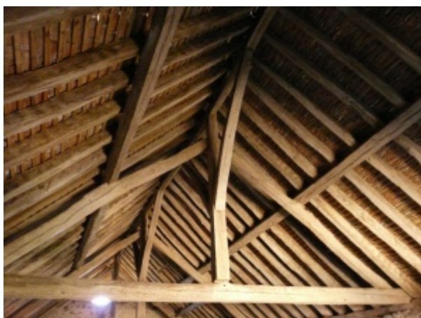
Charpente de la grange de "La Rue" à Avesé (Sarthe).
