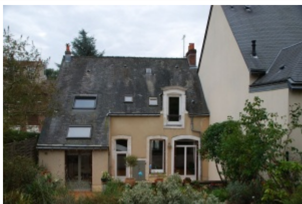
Façade arrière de la maison avant travaux.
