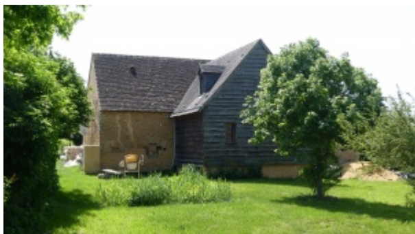
Extension côté nord-est.
