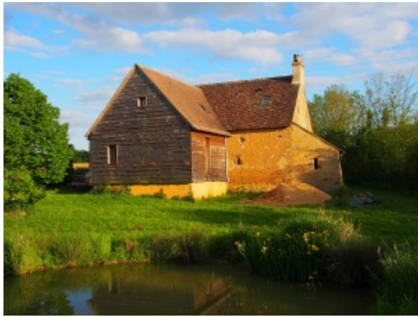
L'extension bardée de bois de châtaignier, côté nord-ouest.
