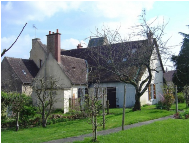
Vue de l'arrière de la maison avant extension. Photo Denis-Marie Lahellec © Maisons Paysannes de France, Délégation de la Sarthe.
