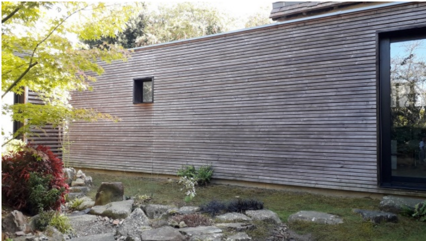
La nouvelle façade, à l'arrière de la maison. Photo Denis-Marie Lahellec © Maisons Paysannes de France, Délégation de la Sarthe.
