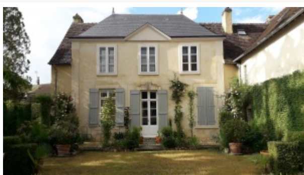
Façade du corps principal après travaux.
