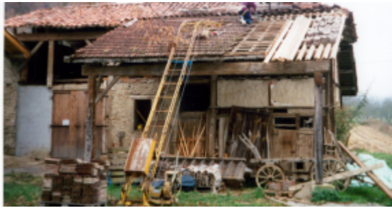
Préau pendant les travaux.
