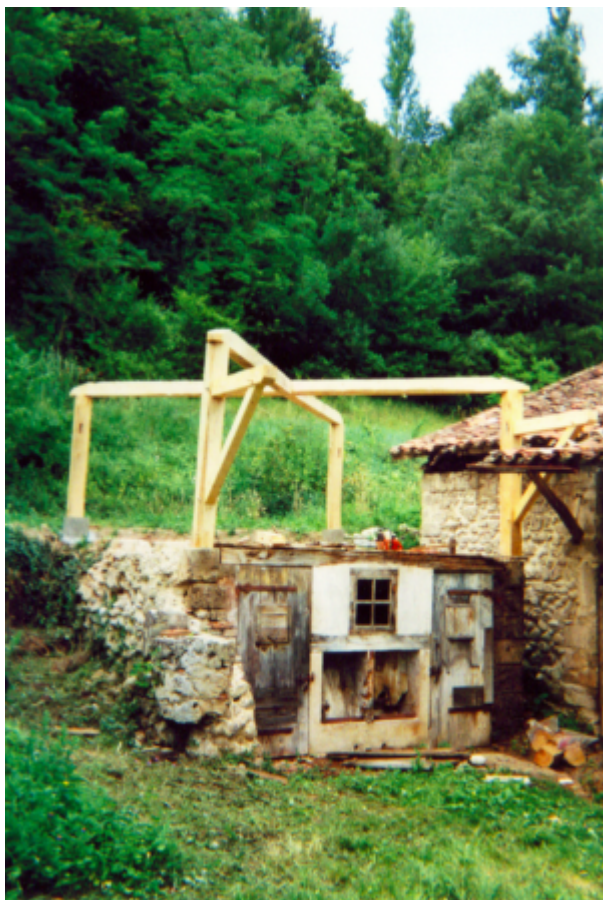
Soue à cochon en restauration.
