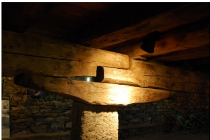
Photo d'un assemblage de liaison entre poutre centrale (charreyre) et poteau. La poutre est simplement posée.
