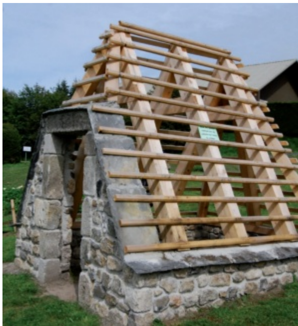
Cabanon démonstratif d'une charpente destinée à la pose du genêt, réalisé par l'association LIGER.
