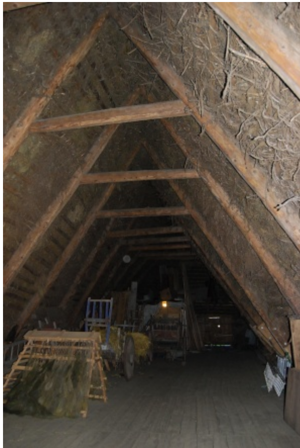
Vue intérieure d'une charpente couverte de genêts.
