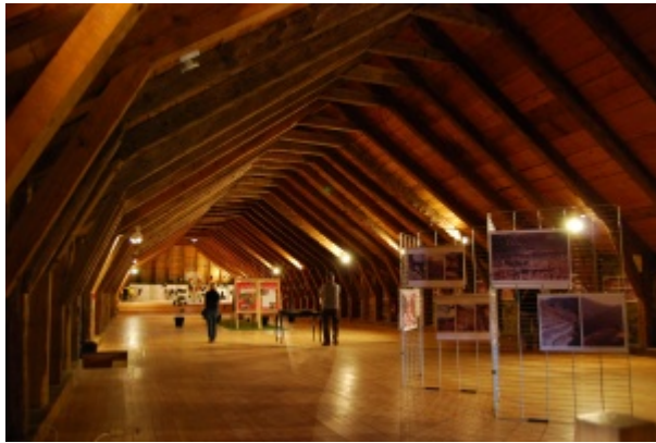
Vue intérieure de la grange. Le toit est couvert de voliges sur lesquelles sont posées des lauzes. Ferme du Bourlatier.
