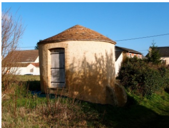
Four à chanvre situé à Saint-Jean d'Assé. L'encadrement est en brique.
