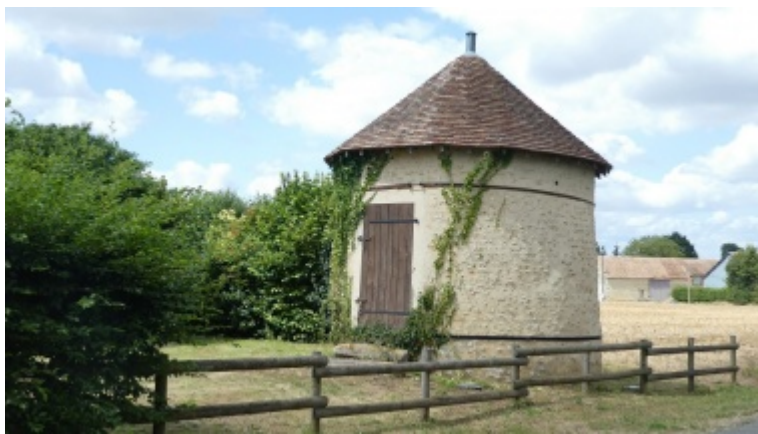
Four à chanvre à Doucelles. Deux cercles de fer renforcent la structure du four.
