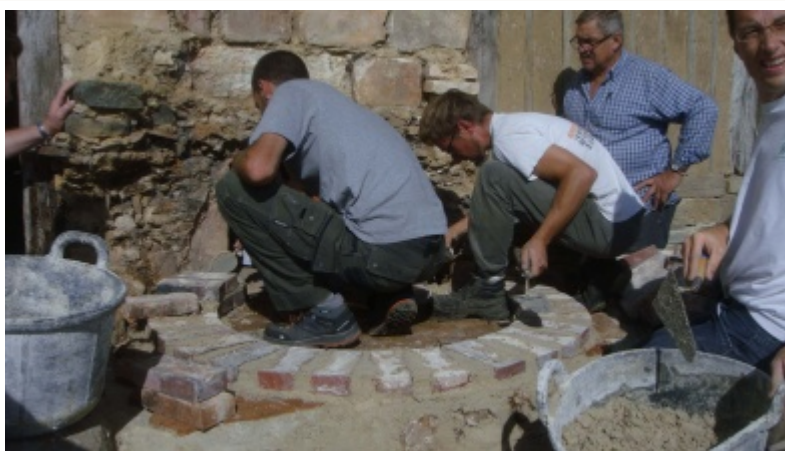
Pose d'un premier rang de brique à plat sur une couche de mortier pour monter la voûte du four.
