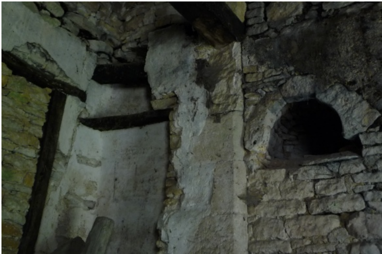
Vue intérieure du four de L'Orée de l'Oze à Gisseysous-Flavigny (21). Le contrecœur a perdu en profondeur suite à l'installation d'un four à gâtir. Photo André Mercuzot © Maisons Paysannes de France, Délégation de Côte-d'Or
