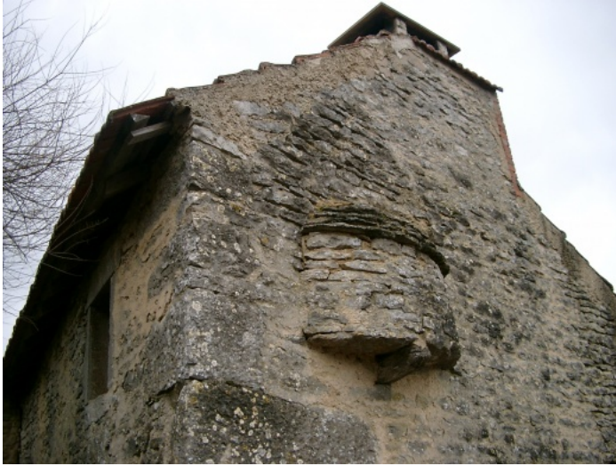
Four suspendu en Côte-D'Or (21), vue extérieure. Photo André Mercuzot © Maisons Paysannes de France, Délégation de Côte-d'Or.
