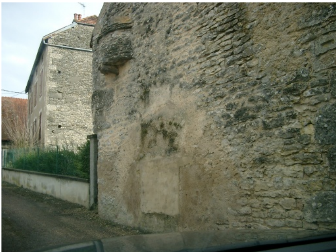
Cul de four à cuire suspendu situé à Rougemont, Côte-d'Or. Photo André Mercuzot © Maisons Paysannes de France, Délégation de Côte-d'Or.
