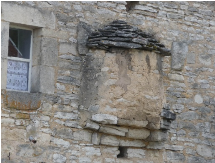
Cul de four à cuire suspendu situé à Rougemont, Côte-d'Or. Photo André Mercuzot © Maisons Paysannes de France, Délégation de Côte-d'Or.
