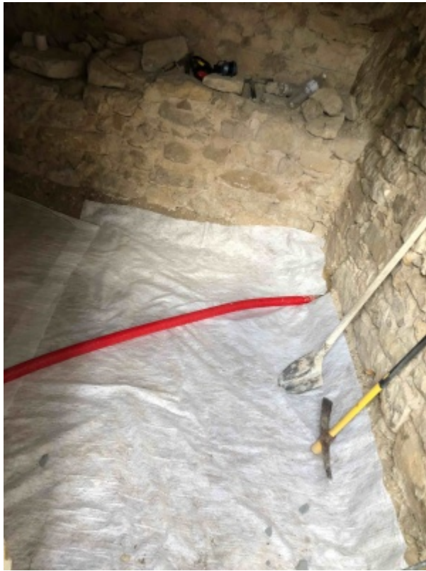
Préparation du hérisson et de la ventilation.
