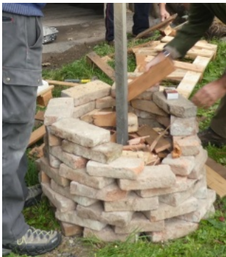
Ajout de bois au fond du four à griya. Photo Maisons Paysannes des Pays de Savoie © 2019.
