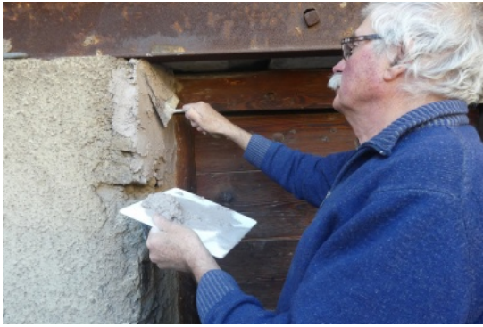
Application de l'enduit de griya tamisé. Photo Maisons Paysannes des Pays de Savoie © 2019.
