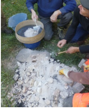
Tamisage de la poudre de griya obtenue après cuisson. Photo Maisons Paysannes des Pays de Savoie © 2019.
