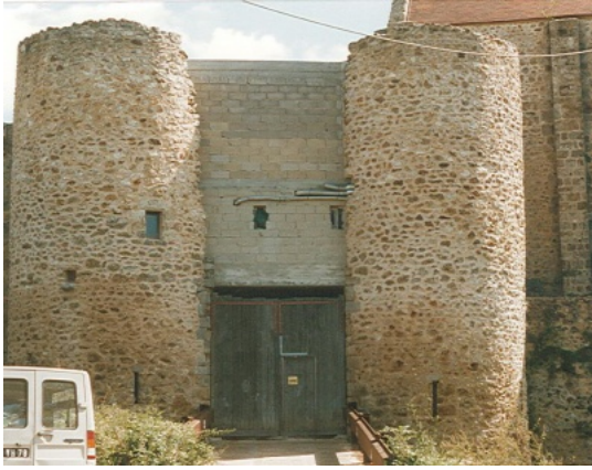
Vue du châtelet avant travaux. Photo PNRHV © Maisons Paysannes de France, Concours René Fontaine 2014-2015.
