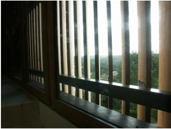
Vue intérieure sur les claustras avec les structures métalliques discrètes. Photo PNRHV © Maisons Paysannes de France, Concours René Fontaine 2014-2015.
