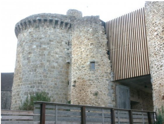
Vue du châtelet et de l'intégration contemporaine. Photo PNRHV © Maisons Paysannes de France, Concours René Fontaine 2014-2015.
