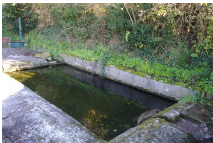
Lavoir ouvert sur source Bors-de-Montmoreau. Trois bords du bassin en pierre sont inclinés afin de pouvoir y battre
