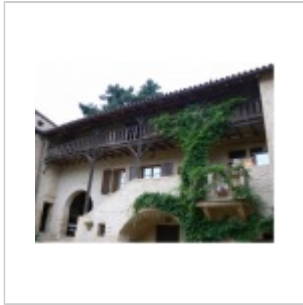
Colonnes et poutan en bois - Ville-sur-Jarnioux.
