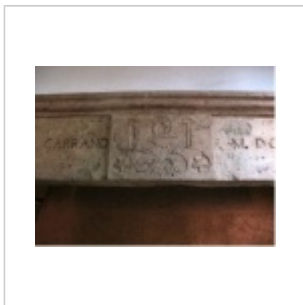
Linteau de cheminée.
