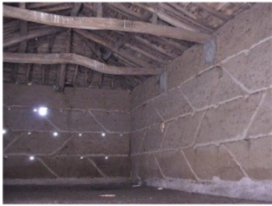
A l'intérieur d'une grange. Succession des banchées croisées alternativement dans un sens et dans l'autre avec un raccordement un biais de 45° et liaison par cordon de chaux. © Photo P. Forissier
