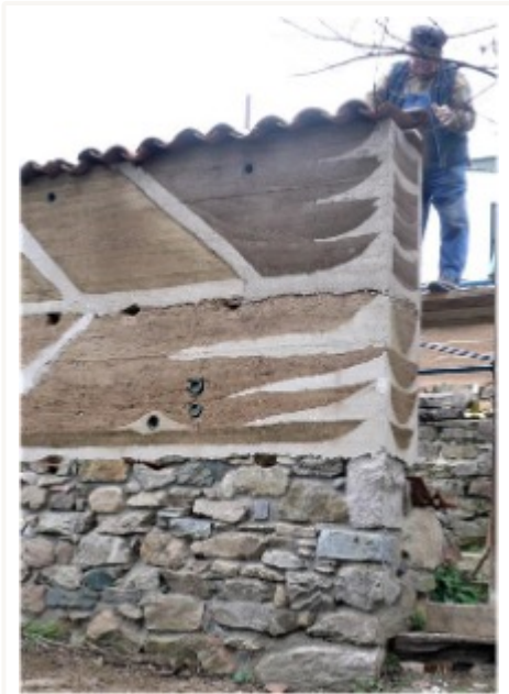
La tête du mur est consolidée par plusieurs cordons de chaux, en forme de branche de sapin. © Photo P. Forissier
