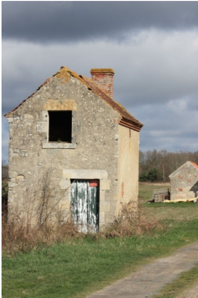
Loge, située sur la voie Genon, Mardié (45).
