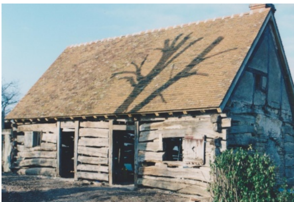
Maison à troncs couchés avec toit restauré. La structure est entièrement dégagée et consolidée avant de pouvoir être recouverte de torchis. Photo Maisons
