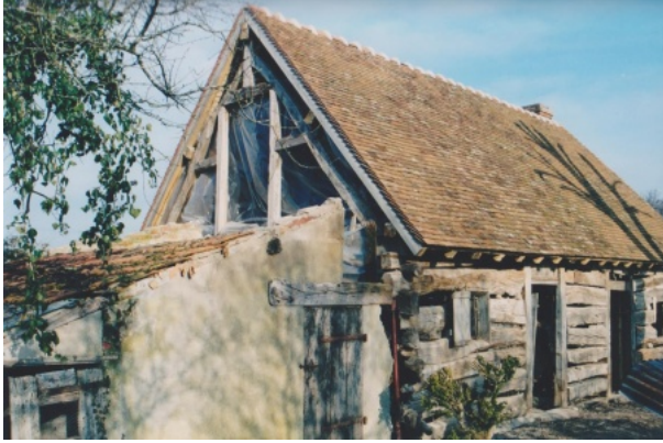
Mur pignon à pan de bois d'une maison à troncs couchés. Photo Maisons Paysannes de France ©
