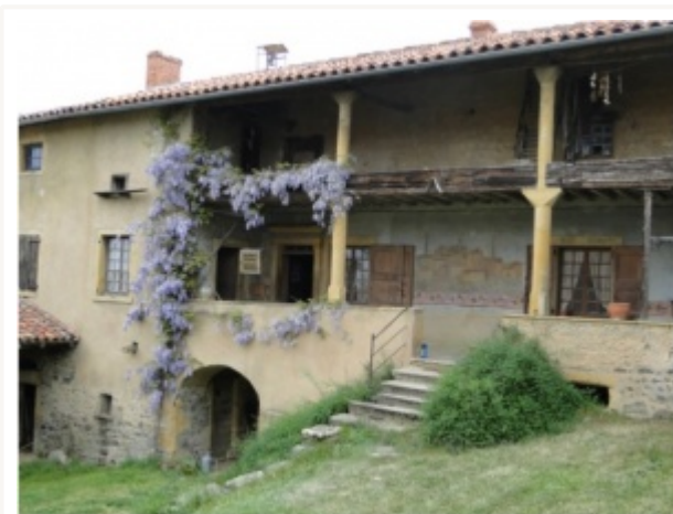
Maisons à galerie, St Julien sur Bibost, Ferme Reverdy. © Pierre Forissier
