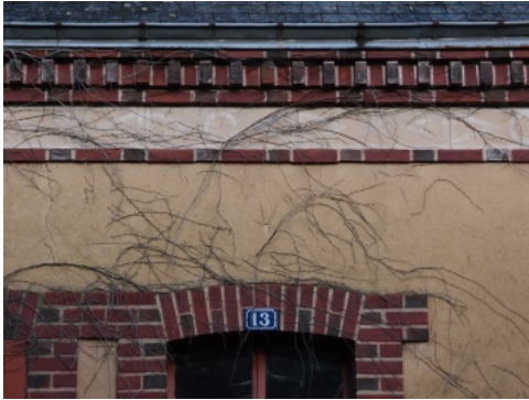
Corniche et encadrements en briques (Sud-est de la Sarthe). Photo Patrick Dejust © Maisons Paysannes de France, Délégation de la Sarthe.
