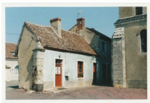
La Chapelle-du-Bois - Maison au pilier, dernier vestige du presbytère.
