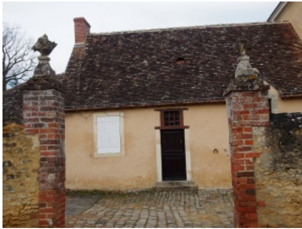
La Jatterie à Connerré: ces octaèdres campent sur des piliers en briques.
