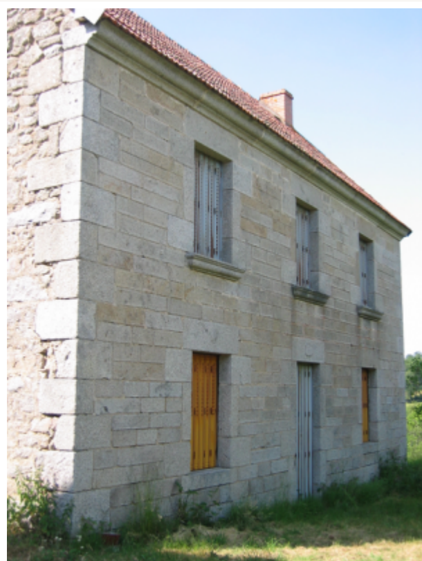
Bâtiment en pierre de taille.
