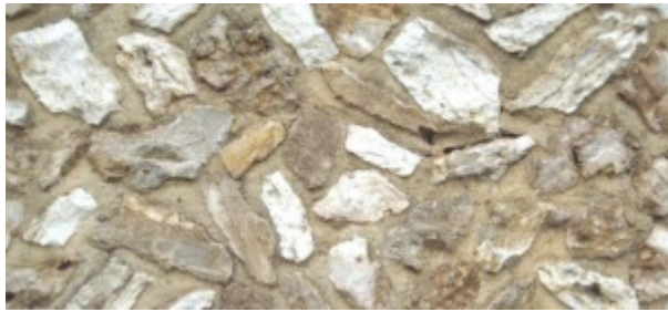
Moellons de silex meuliers compacts à joints plats ou pleins.
