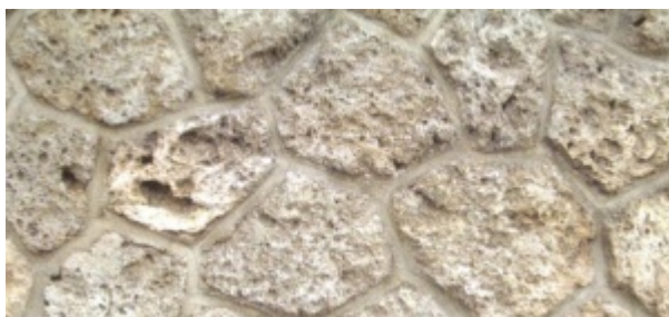
Moellons de silex meuliers caverneux avec joints creux à fond plat.
