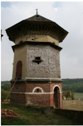
Colombier à pied avec soubassement en briques et partie haute en torchis recouverte de bardeaux de bois, situé à Avesnes- Chaussoy. Photo Jean-François Herlem © Maisons Paysannes de France, délégation de la Somme.
