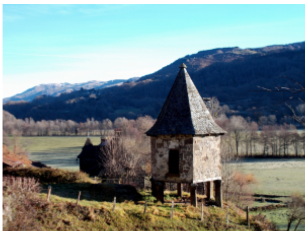
Pigeonnier de la Prade à Vic-sur-Cère; Bâtiment de forme hexagonale aux murs de pierre reposant sur un plancher en bois. Il est juché sur six piliers en pierre chanfreinés. Les encadrements des ouvertures sont en bois. La toiture pentue est couverte de lauzes de schiste et percée sur un pan par une lucarne.
