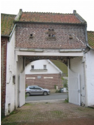
Pigeonnier porche côté cour d'une ferme à Diéval, Pas- de-Calais (62). Photo Jean-François Herlem ©
