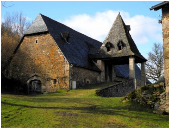
Porche à clocheton de la grange de Sagnabous avec pigeonnier intégré. Photo Henri Sabatier © Maisons Paysannes de France, délégation du Cantal.
