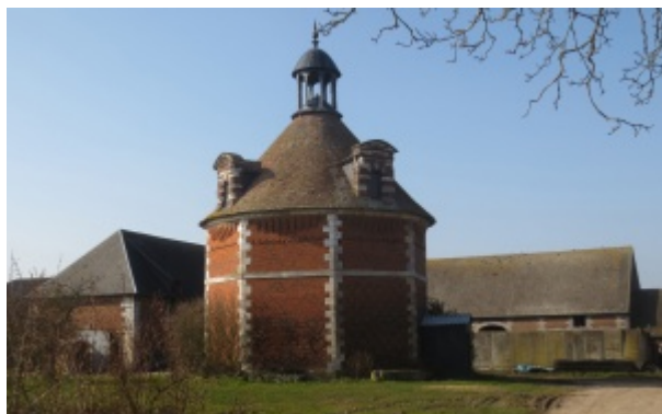
Pigeonnier de la Ferme du Logis, situé à Bourgheroulde (Eure). Imposant pigeonnier en briques avec randière,
