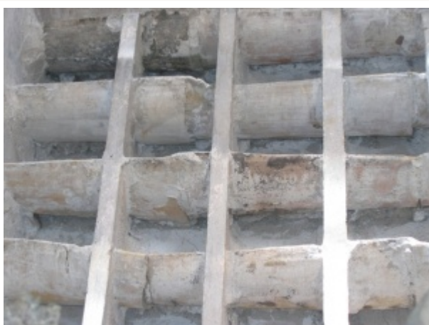
Détail des boulins dans le cabanon du plan des Coulettes à Puimisson (04).
