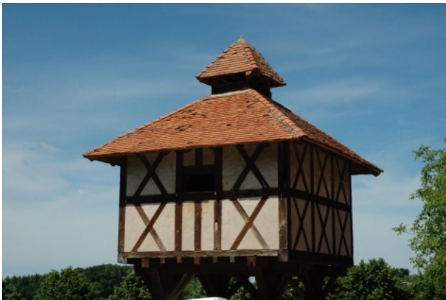
Pigeonnier à pan de bois couvert d'un toit en tuile plate avec clocheton, Nandax (42). Photo Robert Maréchal ©
