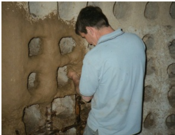
Façonnage des boulins avec du torchis posé sur une armature en baguettes de bois brut.
