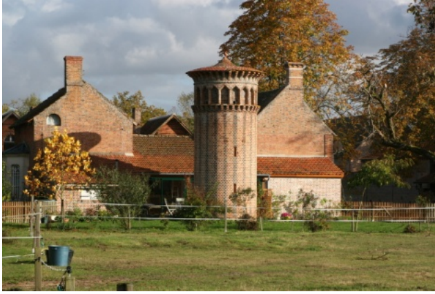
Pigeonnier en Sologne (45). Photo M. Pécaud, Photothèque Maisons Paysannes de France ©
