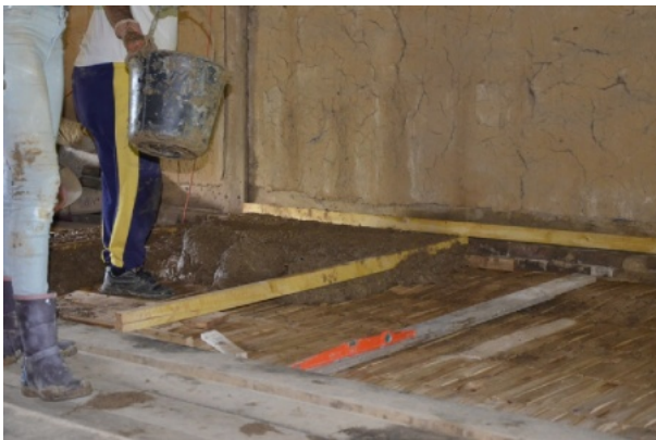
Application de la terre sur les barrelets. Photo Maisons Paysannes de France, Délégation de Normandie, Eure ©
