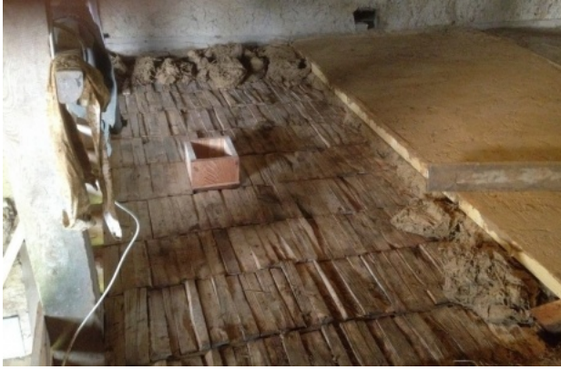
Application de terre sur barrelets. Photo Maisons Paysannes de France, Délégation de Normandie, Eure ©
