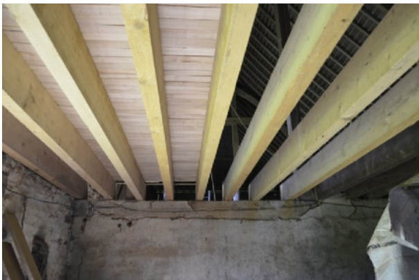
Madriers vue de dessous. Photo Maisons Paysannes de France, Délégation de Normandie, Eure ©
