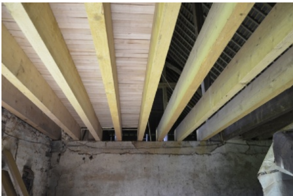
Madrers vue de dessous. Photo Maisons Paysannes de France, Délégation de Normandie, Eure ©
