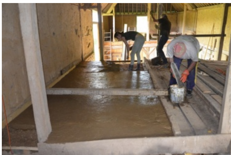
Plancher en terre lissé. Photo Maisons Paysannes de Normandie © Délégation de l'Eure
