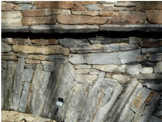
Cible fixée sur les blocs de pierre d'un bandeau afin de faire la mesure topométrique.
