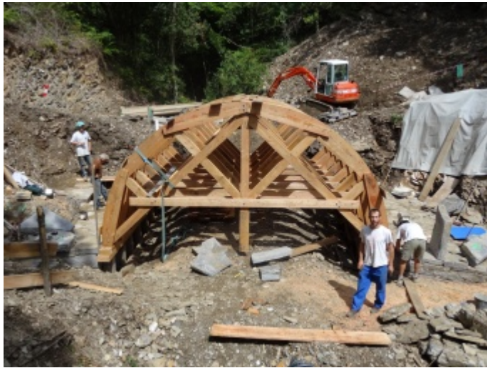
Cintre du pont de Chaldecoste.
