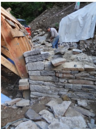
Voûte en construction. Photo Maisons Paysannes de France - Prix René Fontaine ©
