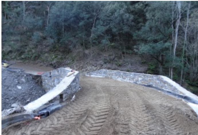
Pose de grave sur la membrane d'étanchéité.
