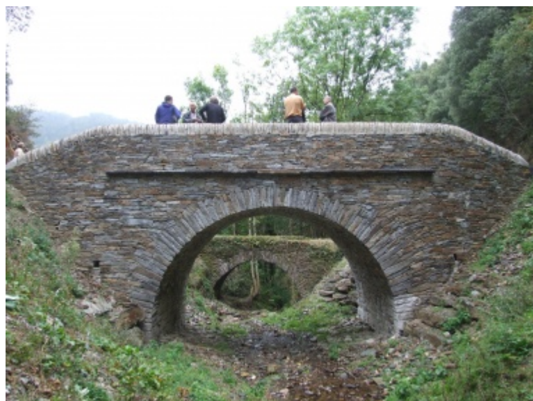
Pont routier de Chaldecoste.
