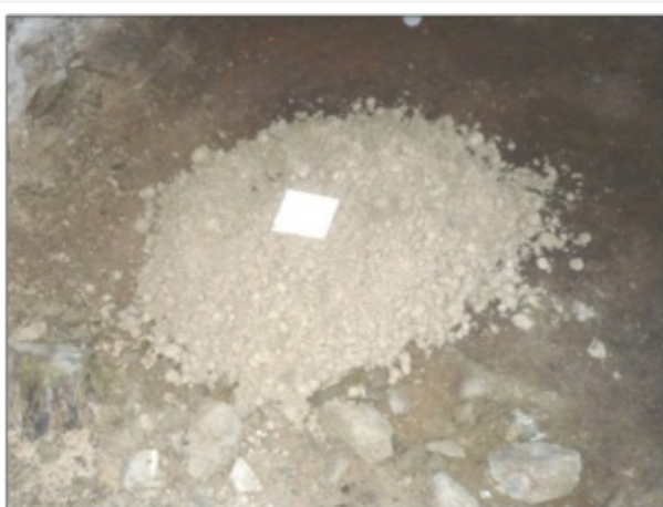
Pose de tomettes 1 - Préparation des plots
