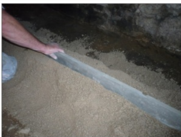
Pose de tomettes 3 - Tirage de la chape
