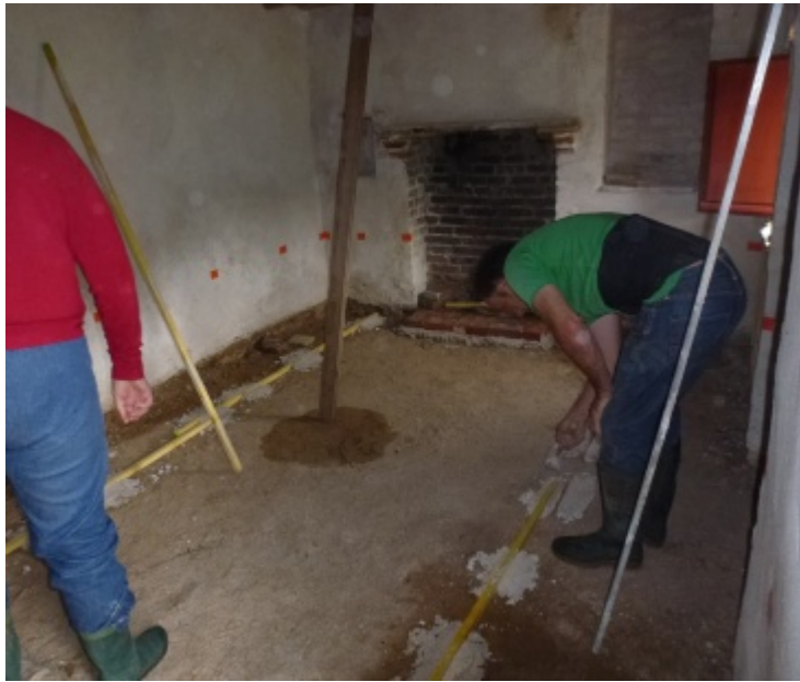
Installation de guides pour la mise en place de la chape.
