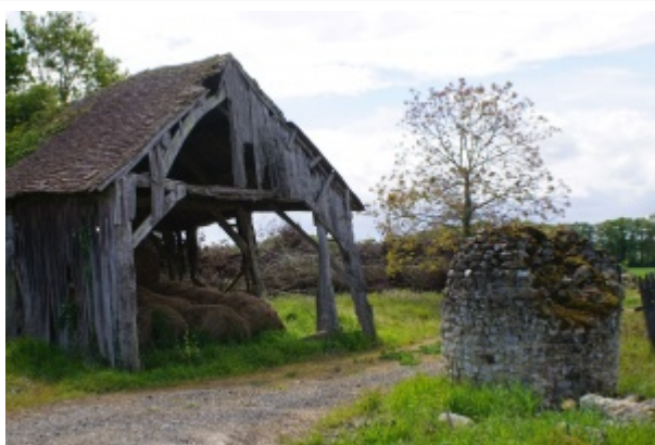
Puits d'une ancienne ferme à Maresché.
