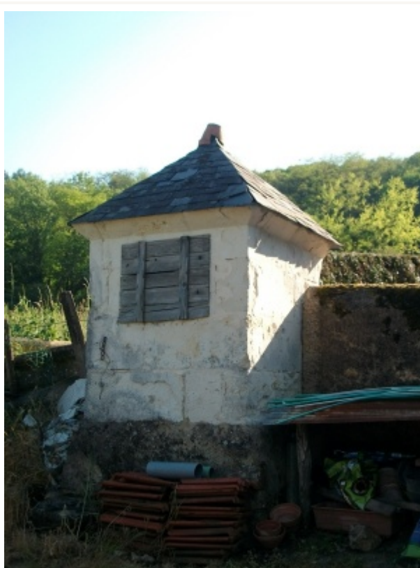
Puits en tuffeau avec couverture en ardoise, vallée du Loir.
