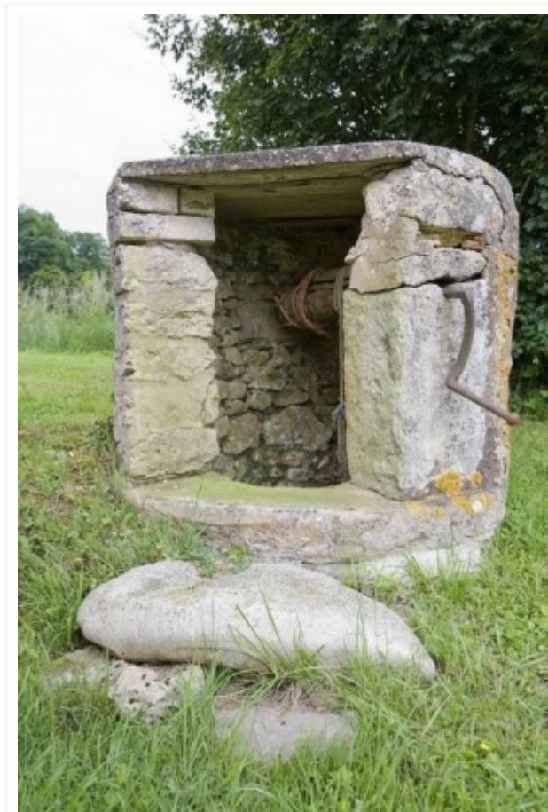
Puits couvert d'une dalle de béton à Courcival.
