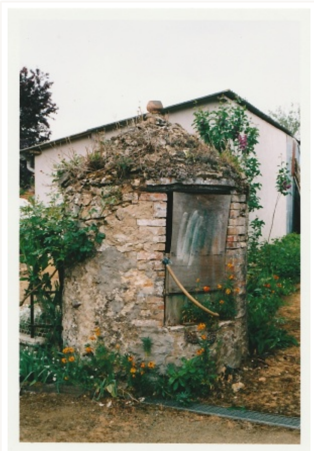
Puits avec toiture en forme de cône, surmonté d'une poterie, à Beaufay.
