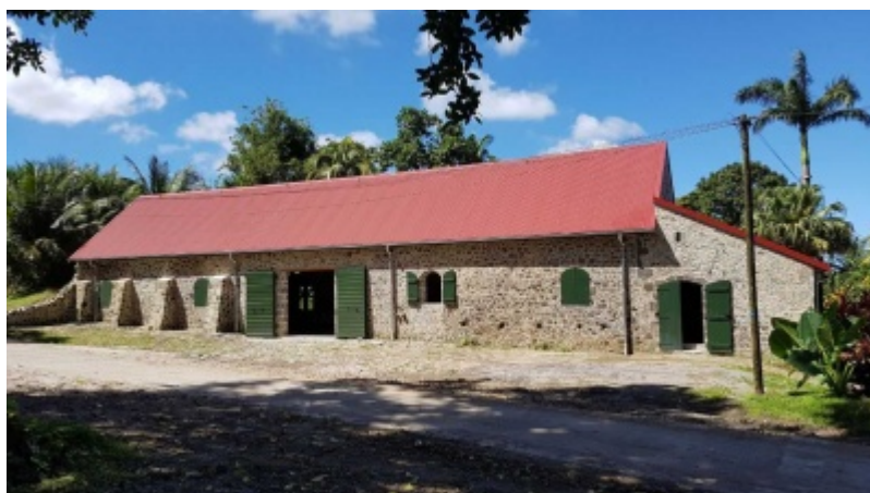
Purgerie après travaux de restauration, Macouba (Martinique).
