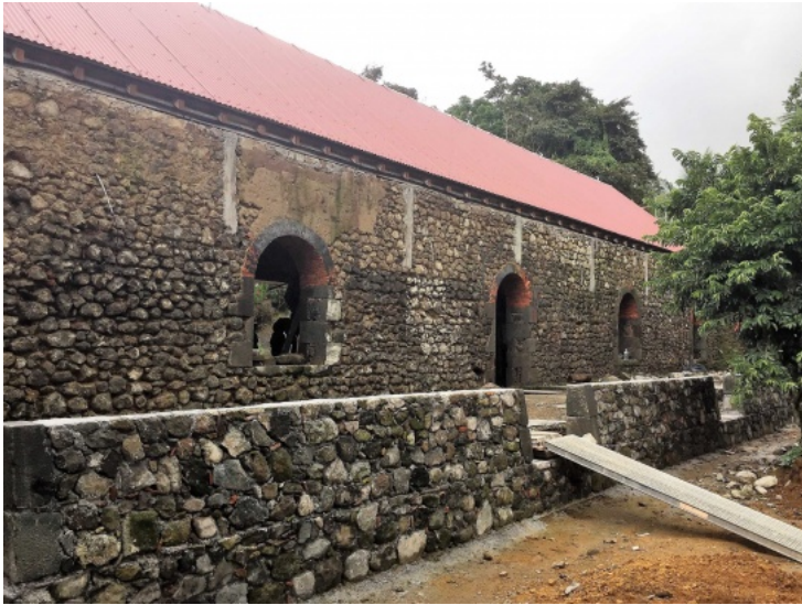
Montage de la galerie arrière de la purgerie. Photo Maisons Paysannes de France, Prix René Fontaine ©
