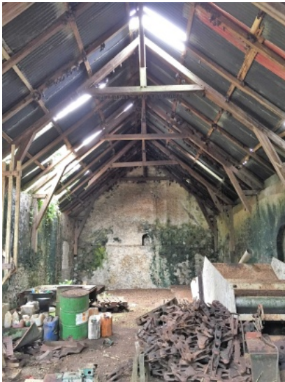
Intérieur de la halle principale de la purgerie avant travaux. Photo Maisons Paysannes de France, Prix René Fontaine
