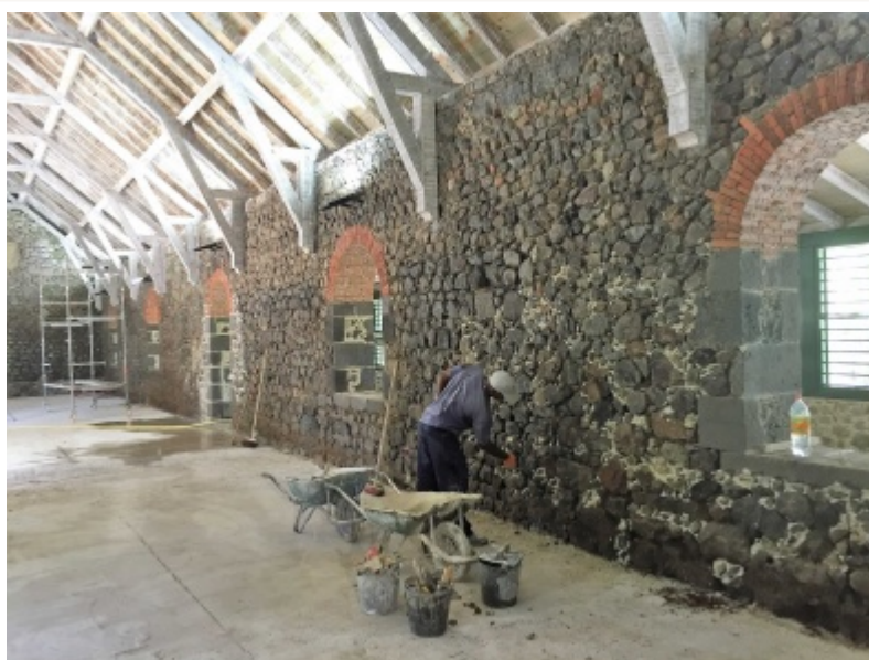
Halle intérieure de la purgerie avant jointage des pierres.
