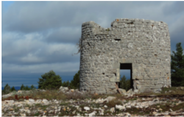
Façade avant restauration
