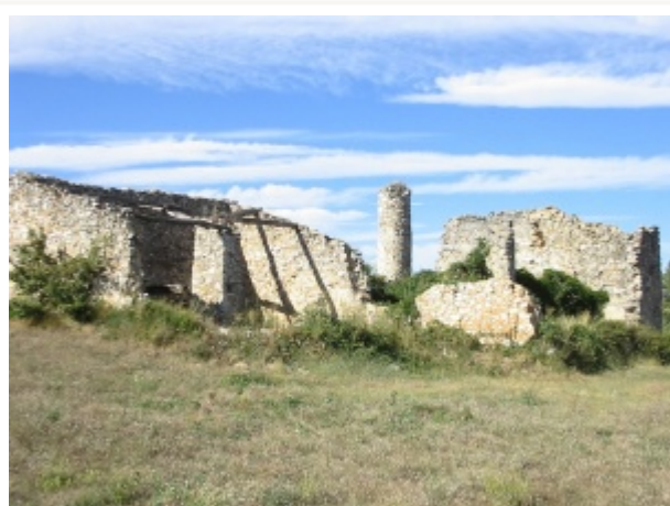
Vue de la bergerie avant travaux
