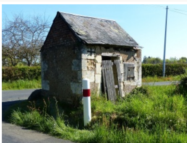
La maison de vigne avant restauration .
