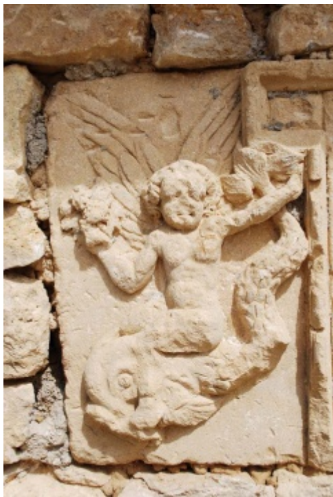
Sculpture retrouvée sous l'enduit ciment de la façade.
