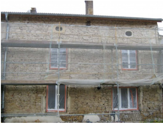
Façade de la maison après piquetage de l'enduit. Photo D. & L. Guillemain © Prix René Fontaine de la Maison de Bourg.
