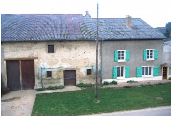
Grange et maison avant restauration. Le toit est en fibrociment. Photo D. & L. Guillemin © Prix René Fontaine de la Maison de Bourg.
