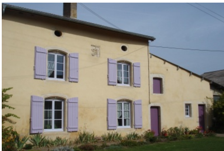
Façade de la maison et du bâti accolé après restauration.
