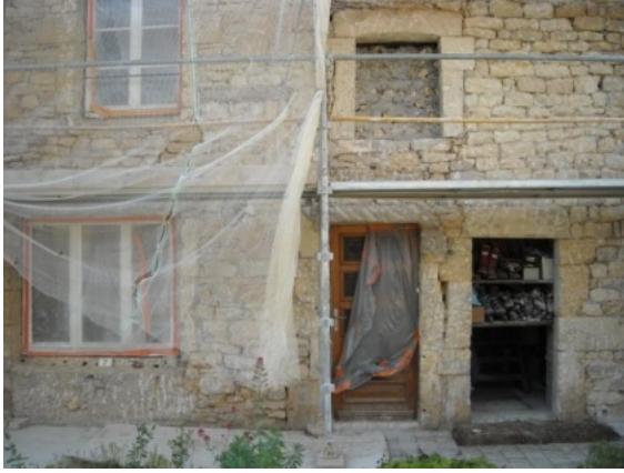
Découverte d'une fenêtre au dessus de la porte. Photo D. & L. Guillemin © Prix René Fontaine de la Maison de Bourg.
