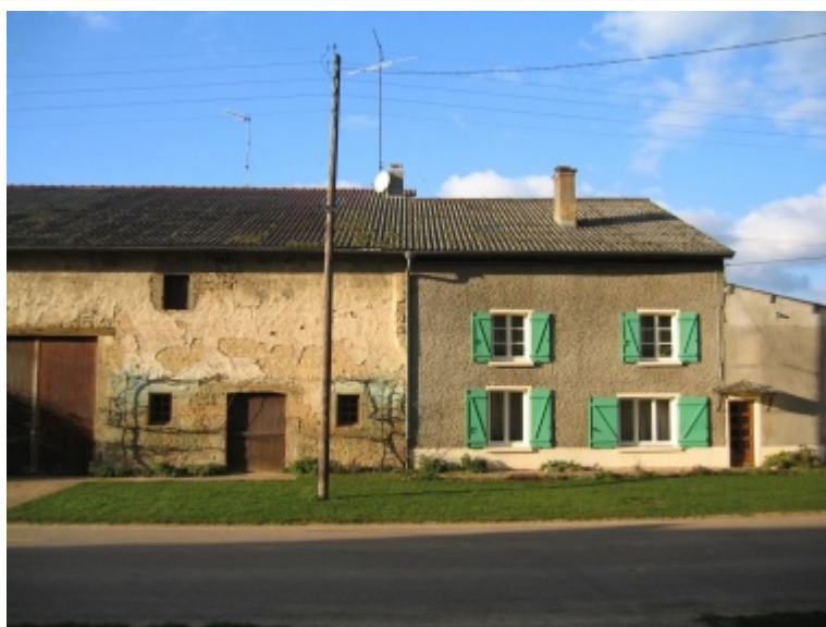
Façade de la maison avant restauration.
