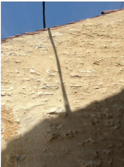
Enduit à pierres vues côté pignon. Photo Fabienne Ferrut © Maisons Paysannes de France, Prix René Fontaine.
