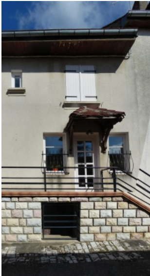
Façade avant travaux. Perron paré de fausses pierres et couvert d'un carrelage flambé. Photo Fabienne Ferrut © Maisons Paysannes de France, Prix René Fontaine.
