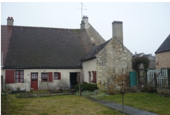
Maison vue du jardin avant travaux. Photo D. & L. Guillemain © Prix René Fontaine de la Maison de Bourg.
