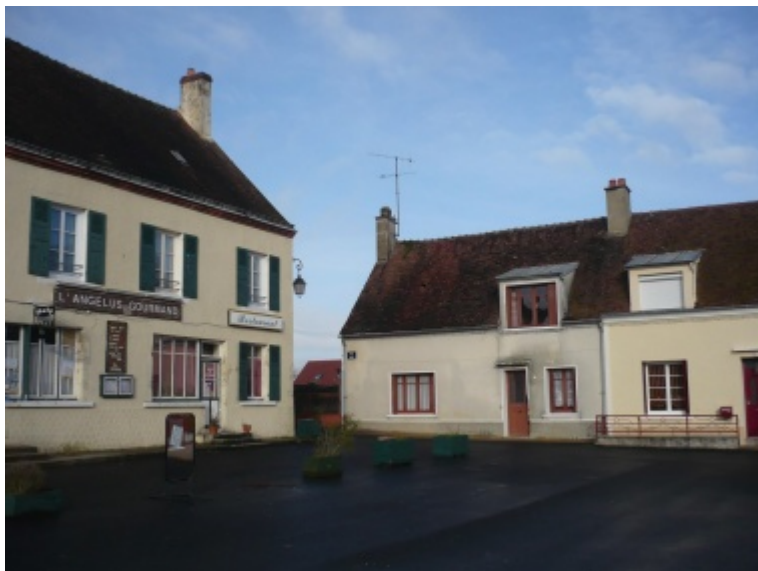
Maison avant restauration à Saint-Hilaire-sur-erre (Orne).
