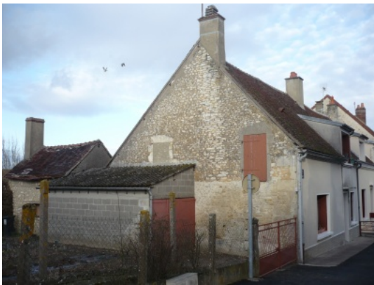
Appentis en parpaing avant restauration de la maison. Photo D. & L. Guillemain © Prix René Fontaine de la Maison de Bourg.
