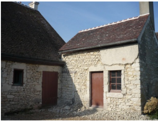
Fournil et arrière de la maison après piquetage de l'enduit ciment. Photo D. & L. Guillemain © Prix René Fontaine de la Maison de Bourg.
