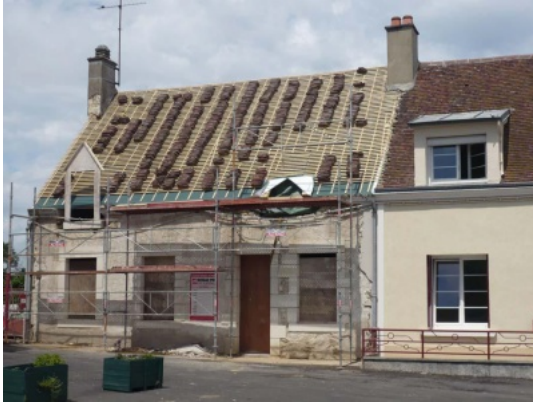
Restauration de la toiture en tuiles plates. Photo D. & L. Guillemain © Prix René Fontaine de la Maison de Bourg.
